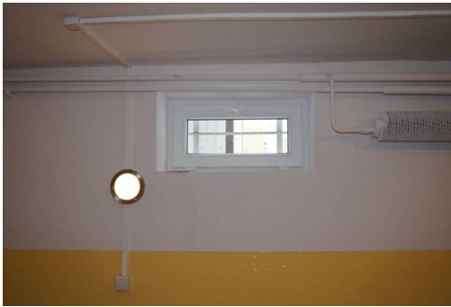
Bild: Nya fönster och lampor installerades.
